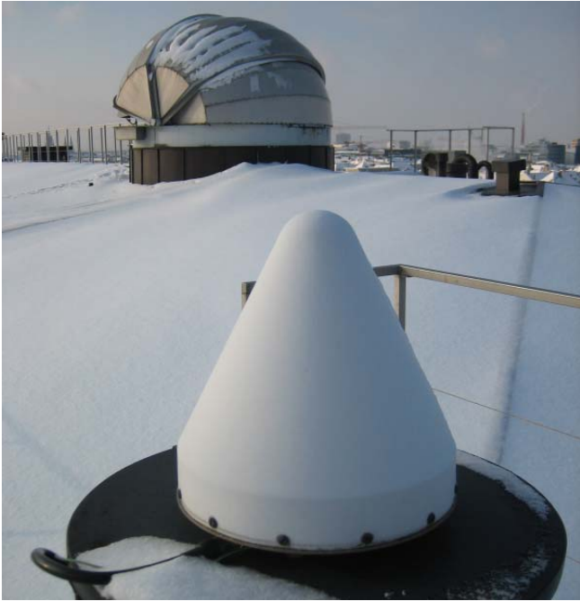
Antenne des GPS-Zeitempfängers auf dem Dach der TUM.
