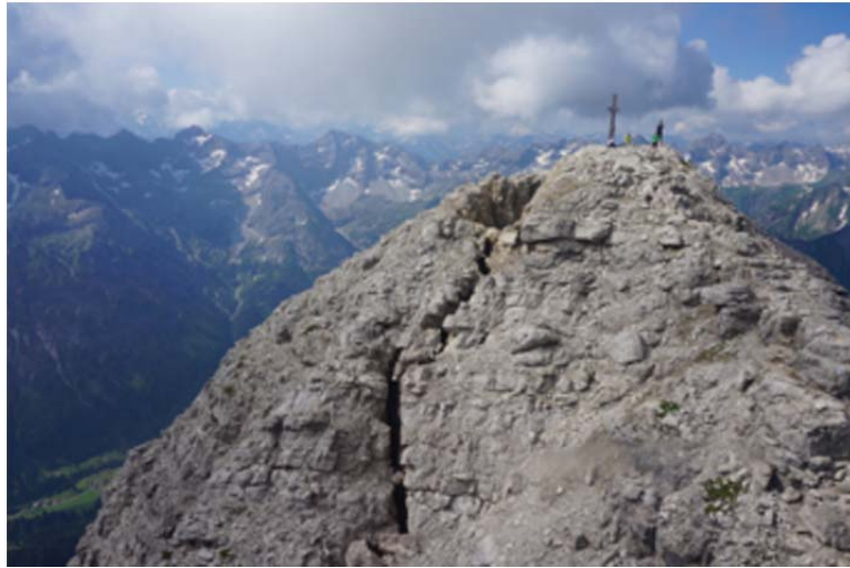
Abb. 1: Untersuchungsgebiet Hochvogel. Blick auf Hauptspalte am Gipfel und sich durch den Gipfelaufbau ziehenden Riss.
